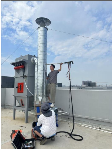
图 4-3 有组织废气监测照片 (DA002 排气筒出口)
