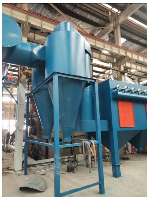
图 4.1-3 旋风分离器+二级滤筒除尘器（TA001）
