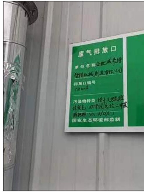
图 4.2-6 DA004 排气筒标识
