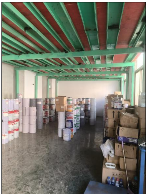
图 4.1-21 漆库防腐防渗
