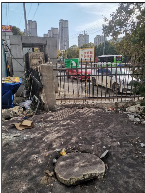
图 4.2-1 污水排放口标识
