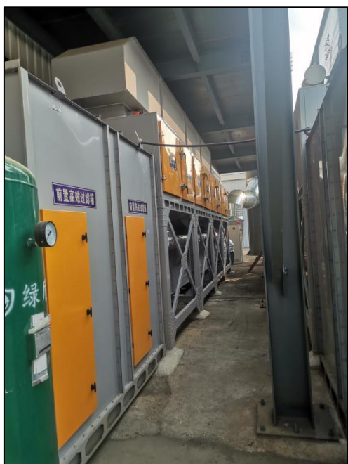
图 4.1-13 废气处理装置 (TA005)
