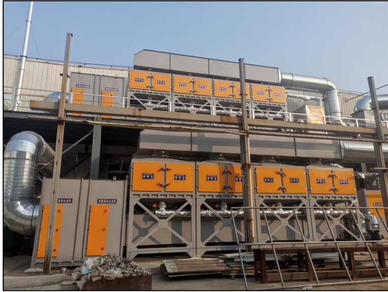
图 4.1-13 废气处理装置 (TA006、TA007)
