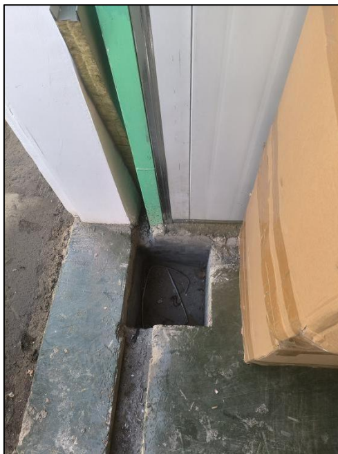
图 4.22 漆库导流沟、集液槽
