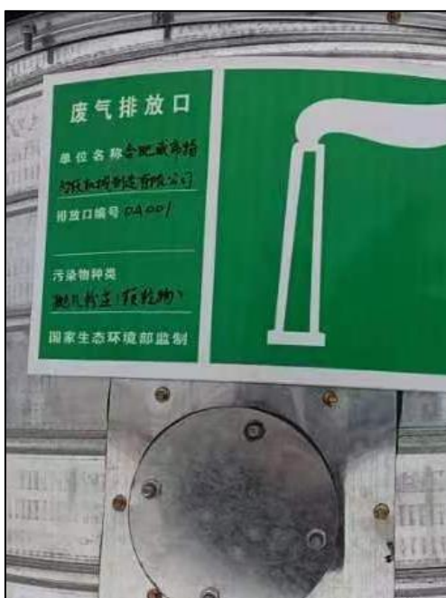
图 4.2-3 DA001 排气筒标识
