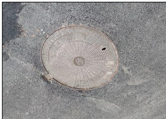
图 4.1-3 厂区污水总排口
